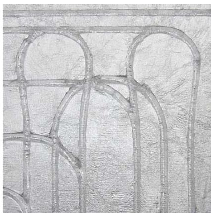
Элемент мультизажимной плиты для зоны разворота труб
