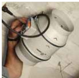
Подключите вентилятор к сети электропитания.
