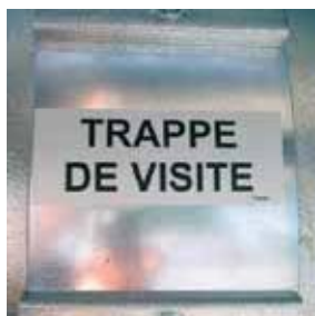
Инспекционная дверца для проведения обслуживания
