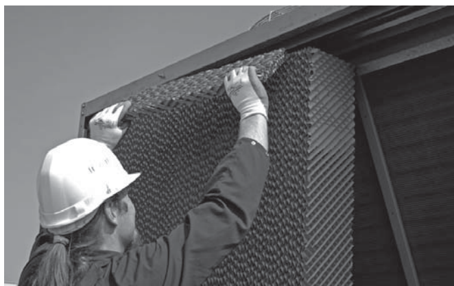
Рисунок 13: Снятие зеленых водораспределительных прокладок
