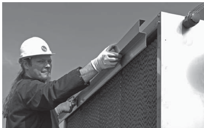
Рисунок 11: Снимите верхнюю пластину
