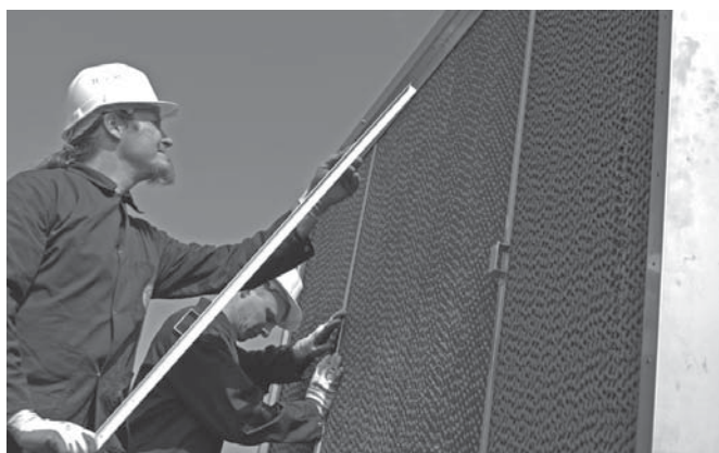
Рисунок 12: Снятие Т-профилей (Т-профили опционные)
