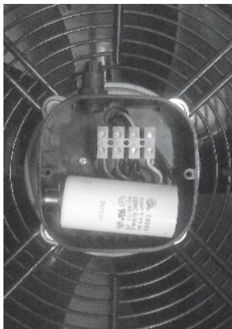
Минимальное сечение электрических проводов – 1 мм<sup>2</sup>
