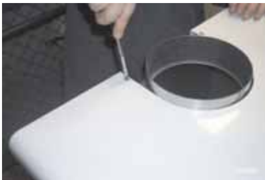
Рис. 3 - Выкрутите два винта - самореза 2, удерживающих крышку котла.
