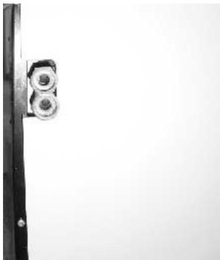
Фото - присоединительная резьба тепловодного вкладыша
