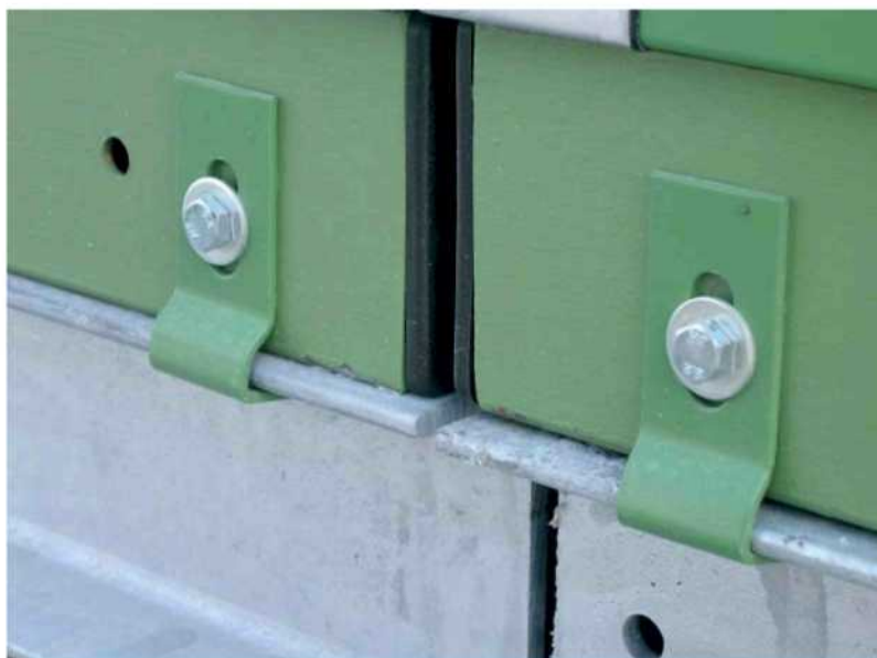
Рис. 2.16. Крепление секций к стальной раме
