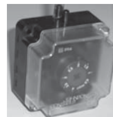
Реле контроля загрязнения фильтра
