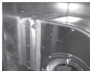
Защитное ограждение привода вентилятора
