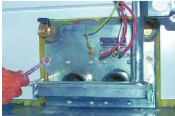
рис. 23 - Демонтаж горелок
