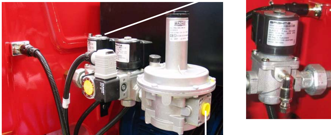
подсоединение к сети распределения газа
