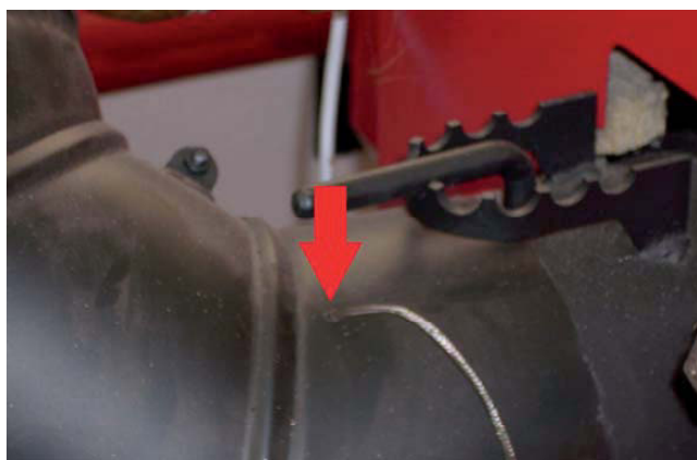
Установка датчика температуры дымовых газов
