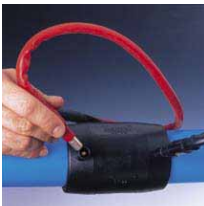
Рис. 35 9. Включить сварочный аппарат, вставить красный кабель в красный контакт
