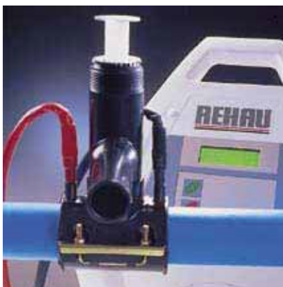
Рис. 46 7. Акустический сигнал известит об окончании процесса сварки. Штекеры после этого могут быть отключены
