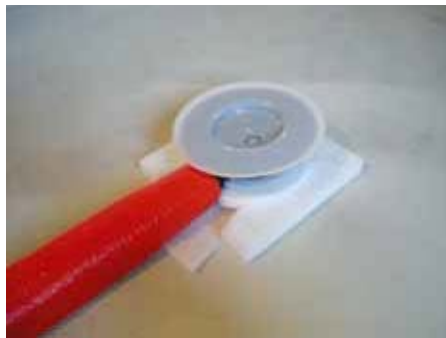
8. Присоединить к трапу канализационную трубу и надеть на нее звукоизоляцию
