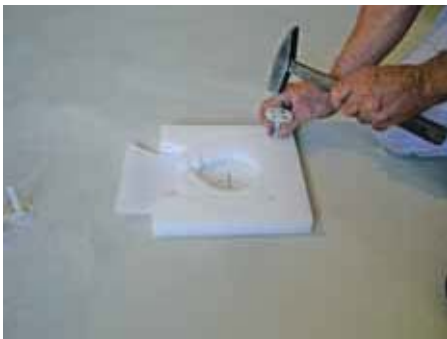
4. Прикрепить с помощью дюбелей нижнюю часть комплекта
