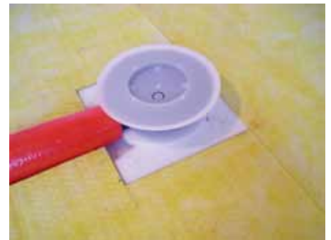
9. Уложить на плиту звукоизоляционные плиты
