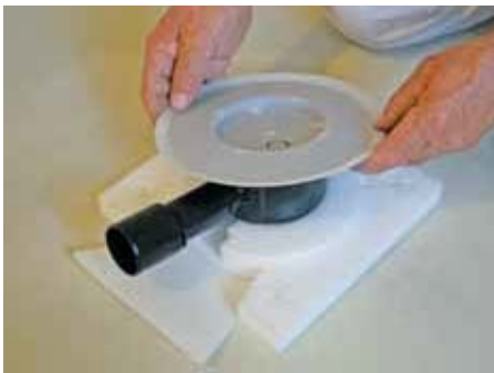
7. Установить корпус трапа с монтажной заглушкой
