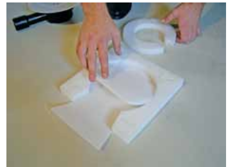
6. При необходимости увеличить высоту установки трапа
