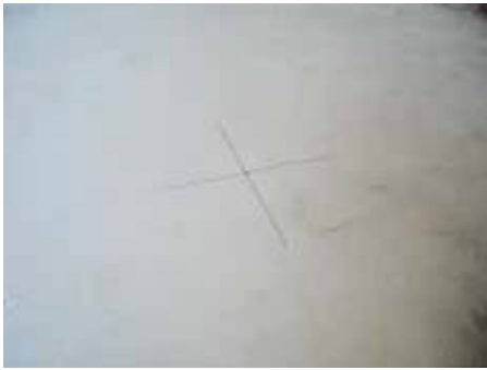
1. Отметить на плите расположение трапа
