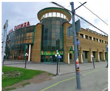
Торгово-развлекательный центр г. Москва Мультизональные системы Dantex
