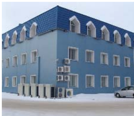
Офисный центр г. Сыктывкар Мультизональные системы Dantex
