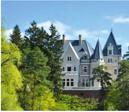
Замок "Майн Дорф" - Резиденция Президента РФ Московская область (Россия) Чиллеры с воздушным охлаждением
