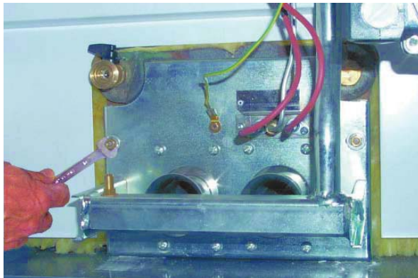
мал. 20 - Демонтаж пальників
