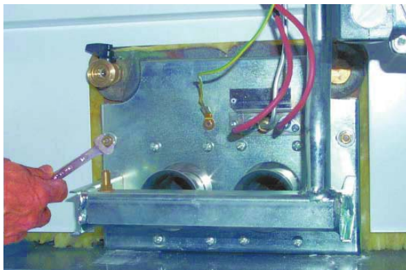
рис. 20 - Демонтаж горелок
