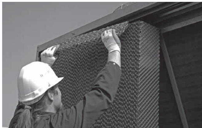
Рисунок 19: Извлечение водораспределительных панелей
