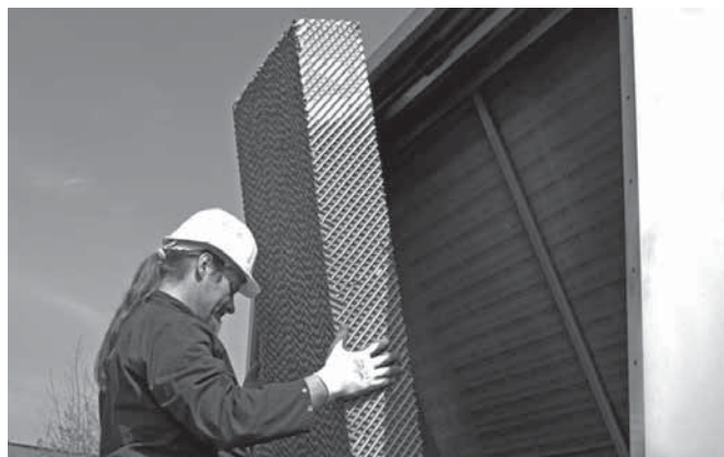
Рисунок 20: Снятие предохладительного материала
