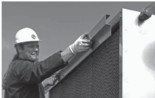
Рисунок 18: Снимите верхнюю пластину
