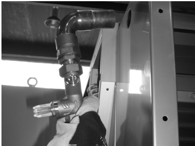
Рисунок 14: Узел подачи воды
