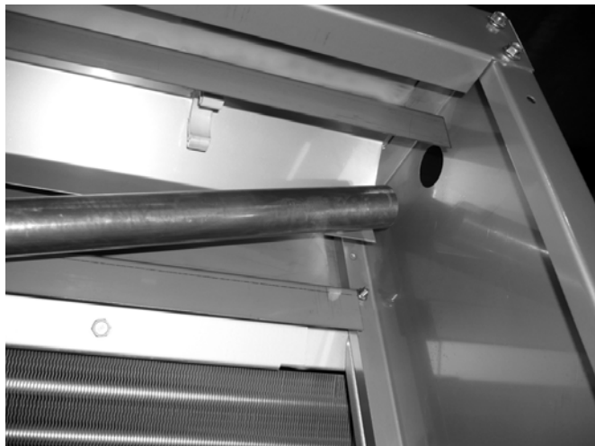
Рисунок 12: Установка медной трубы подачи воды
