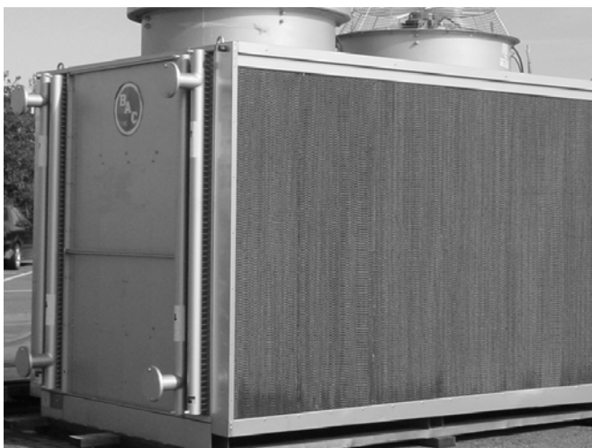
Рисунок 17: Изделие с установленным адиабатическим предохладителем
