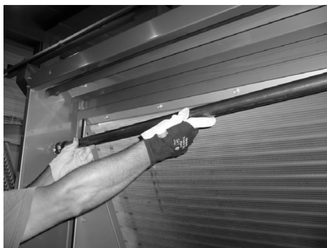
Рисунок 8: Извлеките медную трубу подачи воды
