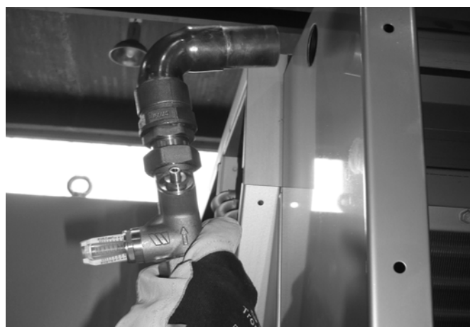
Рисунок 6: Подсоединение подачи воды
