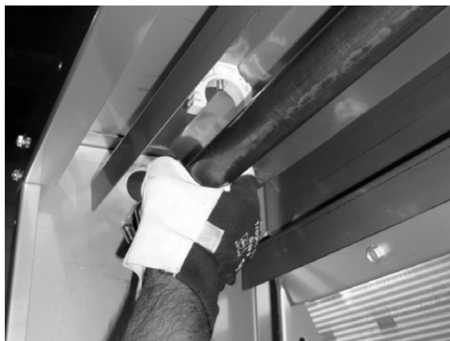
Рисунок 7: Высвободите медный коллектор из пластиковых держателей
