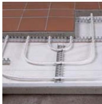
**У-профили:** теплоизоляция укладывается на пол. Сверху кладется полиэтиленовая пленка и устанавливаются U-профили. На профили устанавливаются трубы. Сверху заливается бетон с пластификатором.
