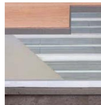
**Сухая система:** теплоизоляция укладывается на пол. Сверху кладутся теплораспределяющие профили. Труба укладывается в профили. Сверху укладывается полиэтиленовая пленка, если будет заливаться бетон. Труба не контактирует непосредственно со стяжкой.
