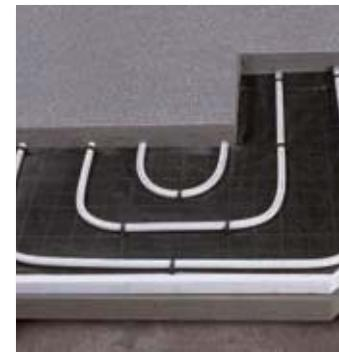
**Степлер:** теплоизоляция укладывается на пол. Сверху кладется полиэтиленовая пленка. С помощью степлера и специальных клипс труба закрепляется на изоляции. Сверху заливается бетон с пластификатором.
