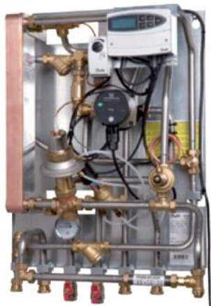
Рис. 8. Малый тепловой пункт модификации Termix VMTD MIX-Q
