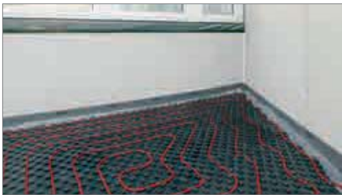
Рис. 4-10 Маты с фиксаторами Varionova с шаговозвукоизоляцией 30-2 снизу
