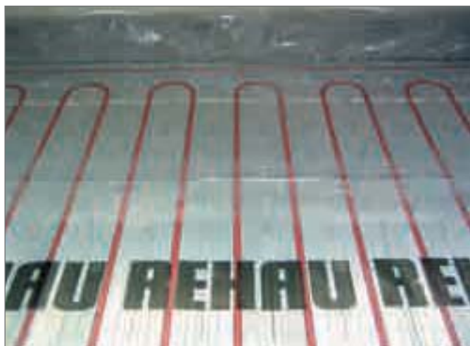
Рис. 4-63 Система укладки труб на теплоизоляционных матах TS-14
