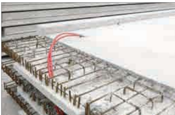
Рис. 9-4 Система REHAU ВКТ из полуготовых модулей
