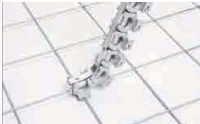
Рис. 4-48 Установить штангу с магазином поворотных клипс
