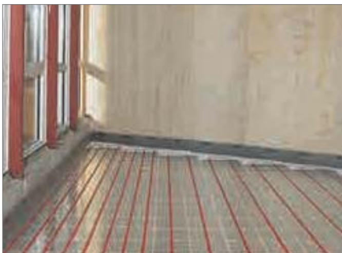
Рис. 4-53 «Сухая» система укладки труб
