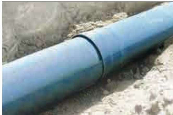
Рис. 13-2 Укладка дренажа на игровом поле
