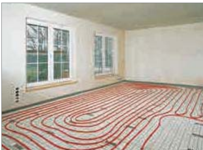
Рис. 4-21 Система крепления труб с помощью гарпун-скоб
