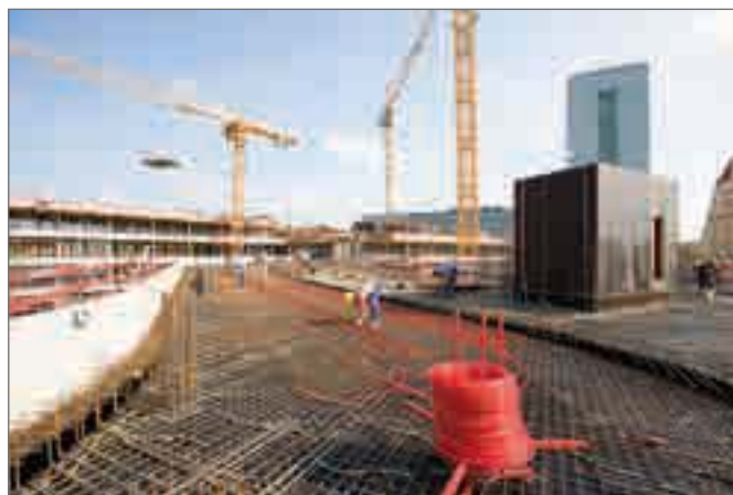
Рис. 9-3 Укладка системы REHAU ВКТ
