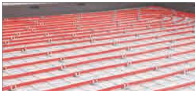
Рис. 4-37 Система крепления труб на арматурной сетке
