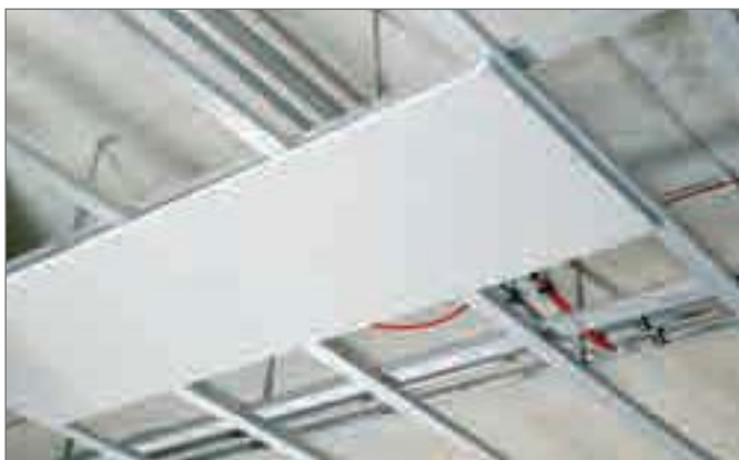
Рис. 5-34 Настенная панель обогрева/охлаждения, смонтированная на потолке
