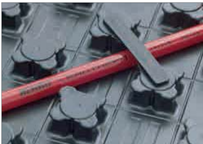
Рис. 4-15 Фиксирующие скобы
