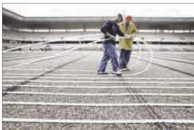
Рис. 13-3 Укладка отопительных труб
