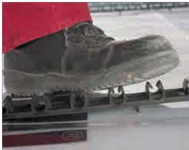
Рис. 4-33 Вдавливание фиксирующих шин RAUFIX в конструкцию пола
