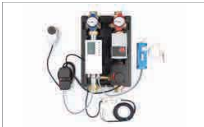
Рис. 8-7 Смесительная станция температурного регулирования TRS-20 ErP
