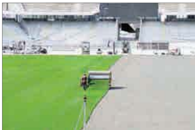
Рис. 13-4 Укладка рулонов газона
