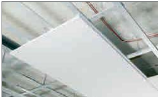
Рис. 5-5 Смонтированный потолочный элемент
