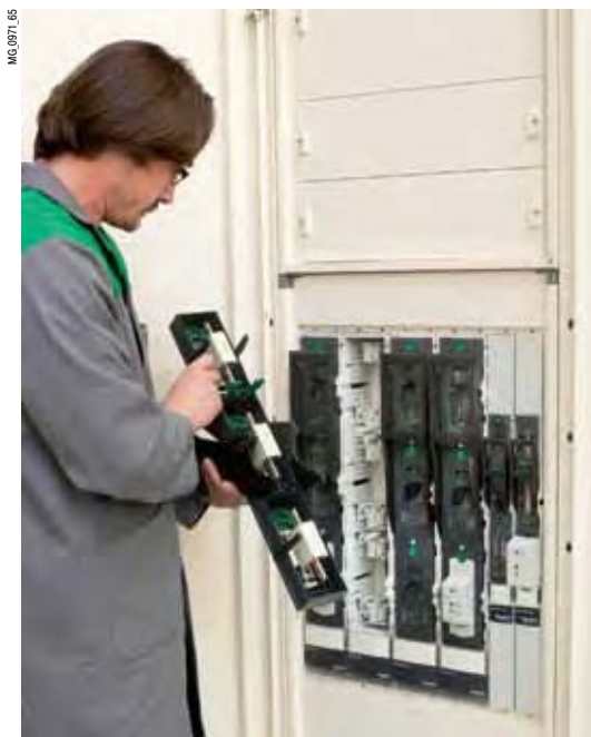
Безопасная замена предохранителей в Fipact ISFL
