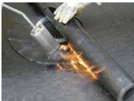
4. Наклеить 2-й слой гидроизоляции (до обжимного фланца)
