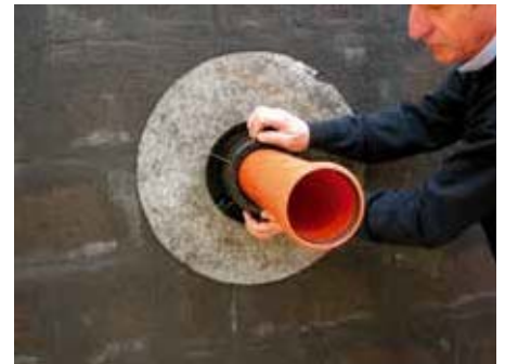
6. Затянуть фиксирующую гайку
