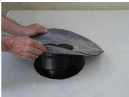
1. Прodelать отверстие Ø 255мм, закрепить воронку HL62H
