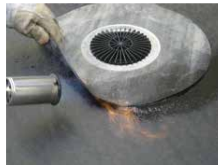
3. Приварить полимербитумное полотно воронки
