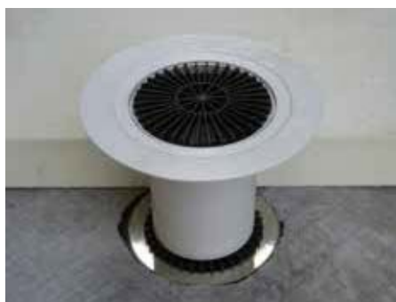
8. Уложить теплоизоляцию, подогнать по высоте надставной элемент HL350.0
