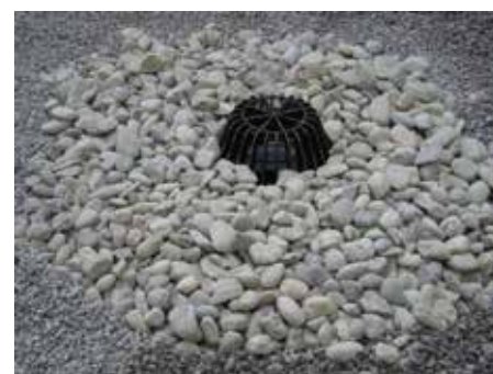
12. Засыпать гравием остальную поверхность кровли
