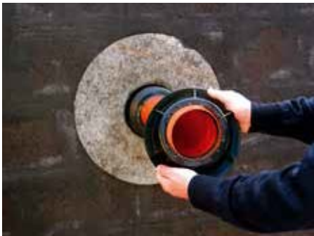
4. Установить фиксирующую гайку
