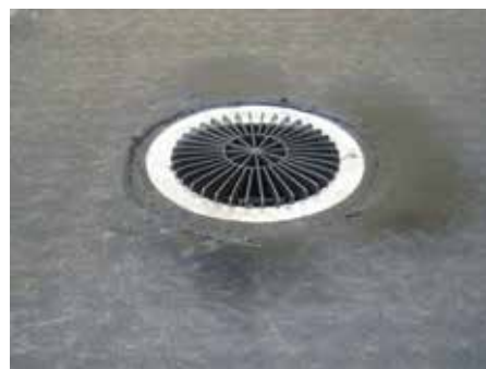
5. Так должна выглядеть воронка после укладки гидроизоляции
