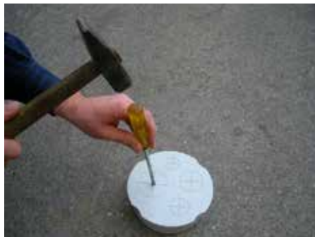
2. В монтажном элементе подготовить отверстия нужного диаметра
