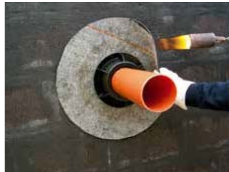
5. Приварить мембрану к битумному покрытию стены
