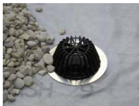
11. Установить листоуловитель, выполнить засыпку гравием (фракция: 20+40 мм)
