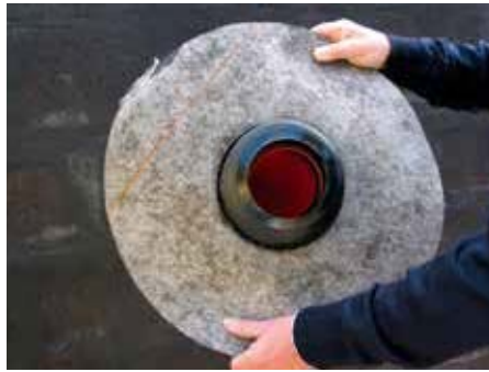
2. Надеть гидроизоляционную мембрану
