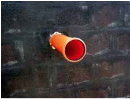
1. Труба проведена через стену с битумным покрытием.
