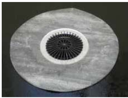
2. Нанести праймер, наклеить 1-й слой гидроизоляции
