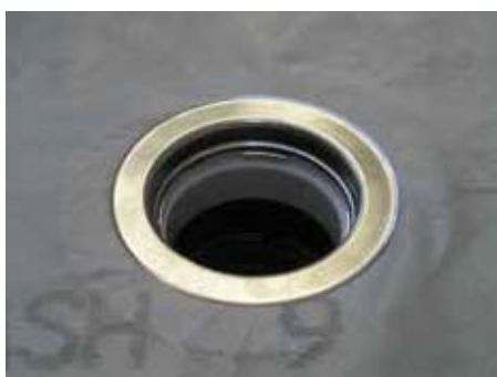
10. Зажать фильтрующий слой фиксирующим фланцем элемента HL350.0
