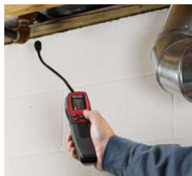
Это бесценный инструмент для персонала, занимающегося монтажом инженерных сетей и техническим обслуживанием
