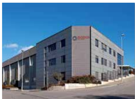
● Завод в Торелло (Испания)
