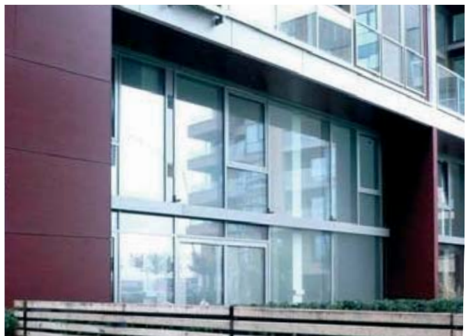
Building: Yoo Wohnanlage, Hamburg
