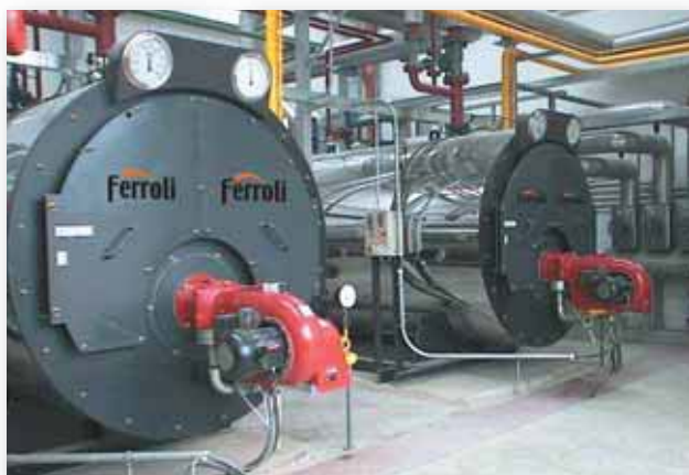
Трехходовой генератор перегретой воды, модель PREX 3G ASH 1500, полезная тепловая мощность 1,744 кВт (1,500,000 Ккал/ч). Высокий КПД, низкая эмиссия NOx.
