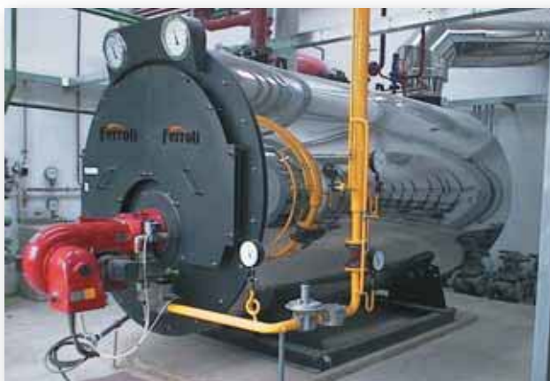
Трехходовой генератор перегретой воды, модель PREX 3G ASH 1500, полезная тепловая мощность 1,744 кВт (1,500,000 Ккал/ч). Высокий КПД, низкая эмиссия NOx.
