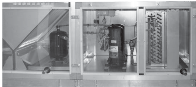
Рис. 16. Встроенный компрессорно-конденсаторный блок
