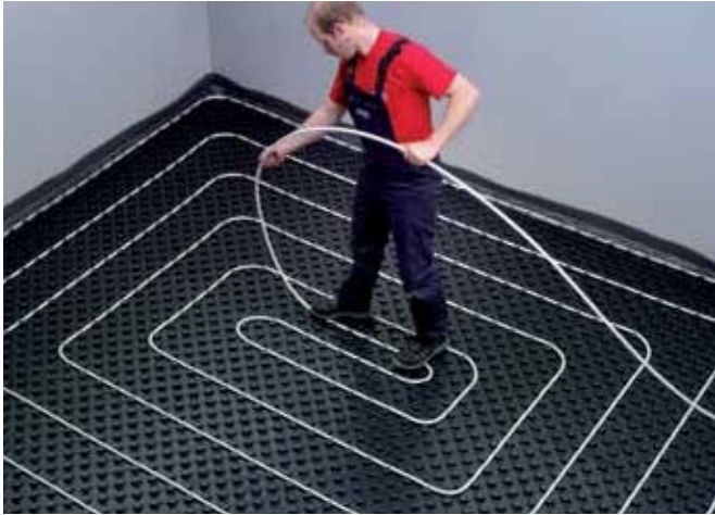
Трубу укладывают по спирали .
