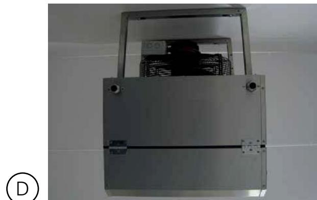
5. Для потока воздуха в вертикальном направлении тепловентилятор устанавливается на конструкциях перекрытия как показано на фото D. Расстояние до стены должно быть не менее 700 мм. Если аппарат монтируется в потолке в зоне угла между стенами, расстояние до одной из них должно быть не менее 700 мм, а до другой не менее 2000 мм. Убедитесь, что несущие конструкции перекрытия выдерживают нагрузку от веса тепловентилятора.
