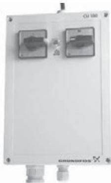
Рис. 118. Шкаф управления CU 100
