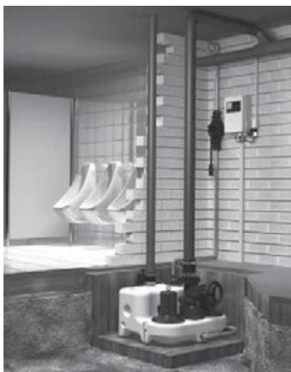
Рис. 94. Пример установки Multilift MD в прямке в подвальном помещении здания
