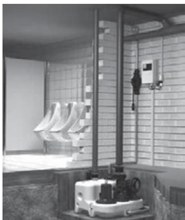
Рис. 103. Пример установки Multilift MDG в прямке в подвальном помещении здания
