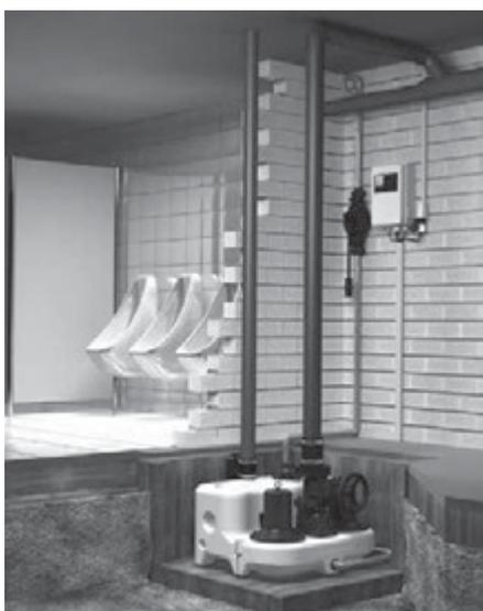
Рис. 99. Пример установки Multilift MLD в приямок в подвальном помещении здания
