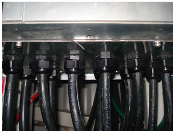
Рисунок 3.25: Пример правильной установки платы уплотнений.
