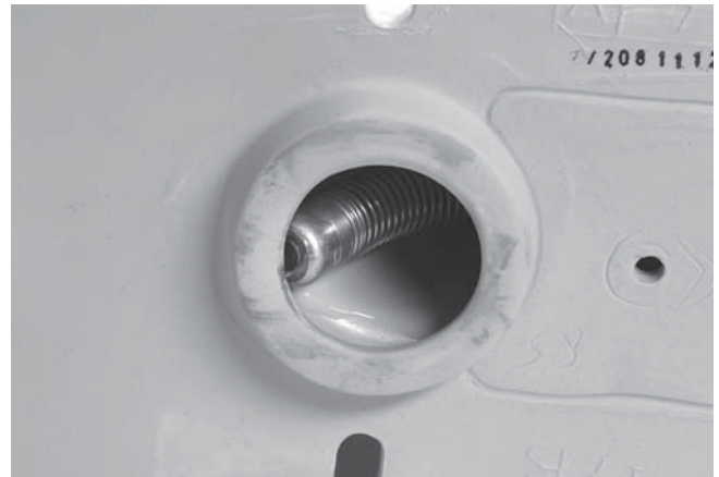
Figura 20 – Cámara atascada en una curva
