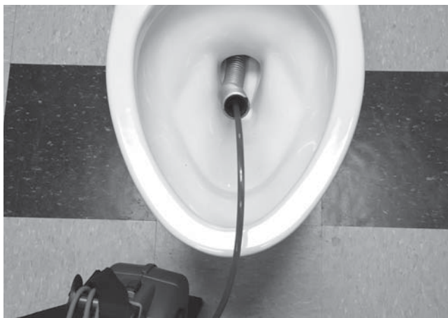
Figure 25 – Utilisation d'un guide flexible
