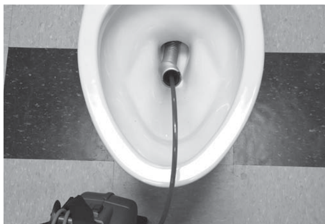
Figura 25 – Utilizarea unui tub de ghidaj flexibil
