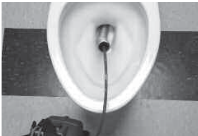
Ilustracja 25 – Używanie elastycznej rurki prowadzącej
