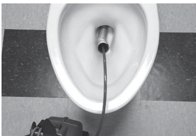
Figur 25 – Användning av en flexibel styrningslang
