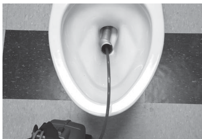
Obrázok 25 – Použitie flexibilnej navádzacej trubice
