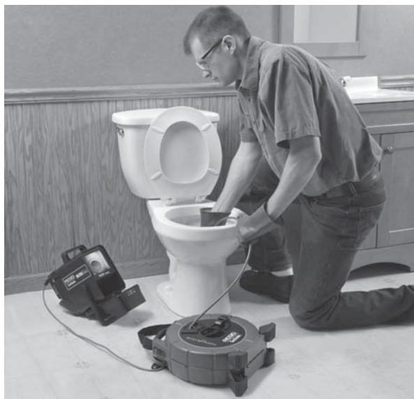
Abbildung 15 – Durchführung einer Inspektion
