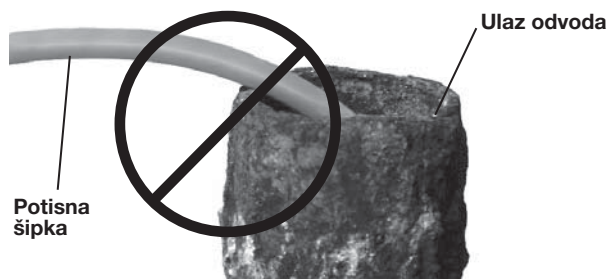
Slika 18 – Izbjegavajte povlačenje po oštrim rubovima
