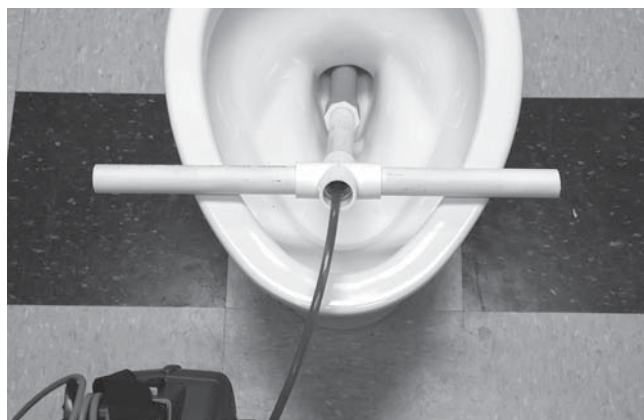
Figura 24 – Utilizarea unui tub de ghidaj din PVC
