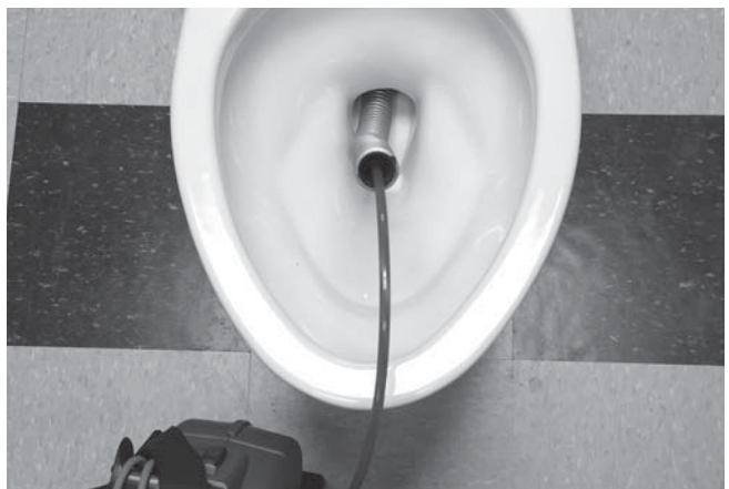
Figura 25 – Empleo de un tubo guía flexible estriado
