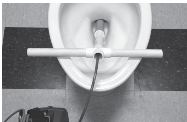
Εικόνα 24 – Χρήση σωλήνα οδηγού PVC
