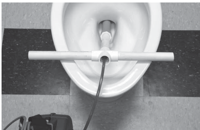
Figur 24 – Användning av en PVC-styrningslang
