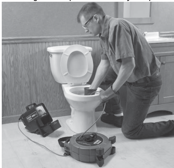
Figur 15 – Utføre en inspeksjon
