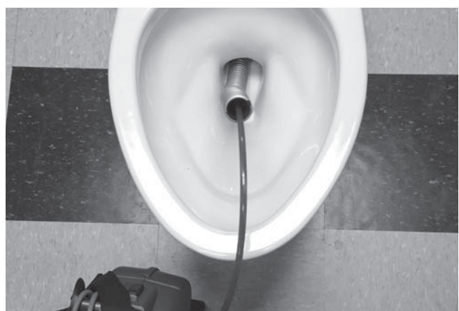
Figuur 25 – Het buigbaar geleiderbuisje gebruiken
