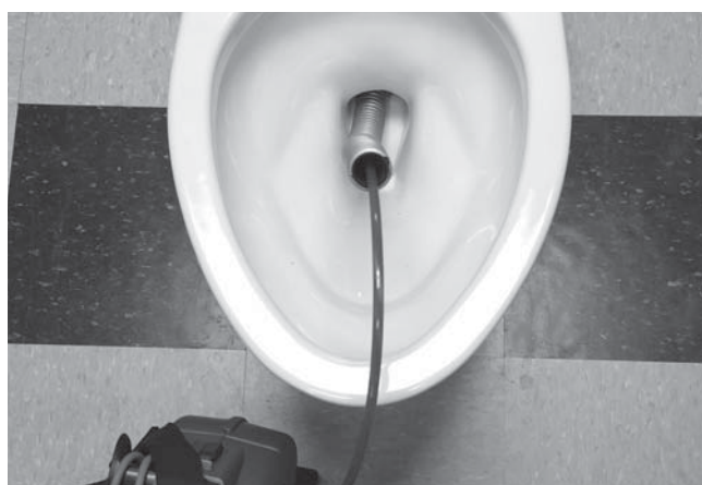
Рис. 25. Использование гибкой направляющей трубы
