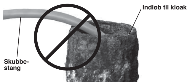
Figur 18 – Undgå at trække ved skarpe vinkler
