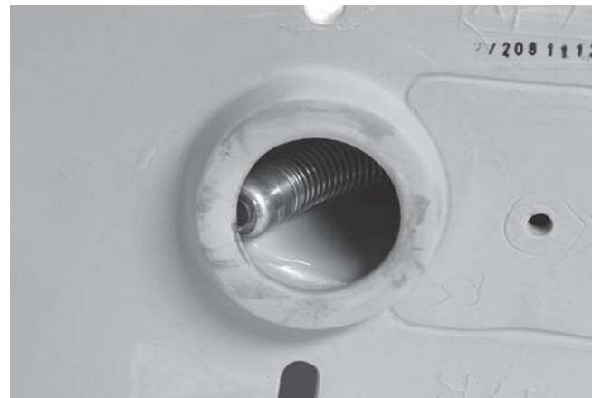
Kuva 20 – kamerapää tukkiutuneena käännöskohdassa
