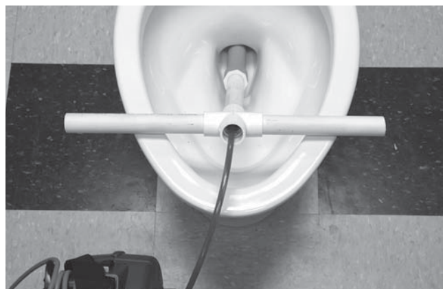
Figura 24 – Utilização de um tubo guia de PVC
