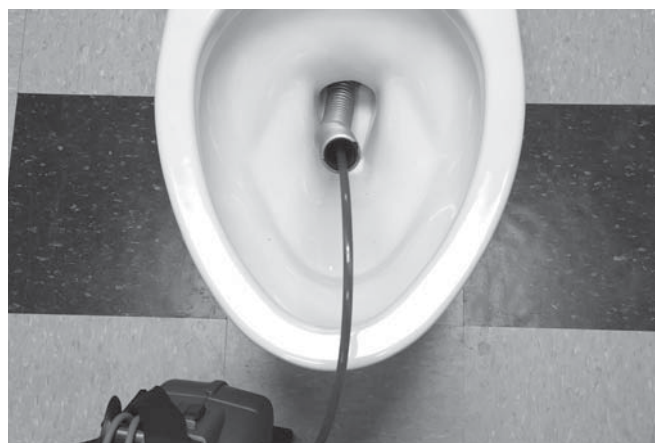
Abbildung 25 – Verwendung eines Führungsschlauchs
