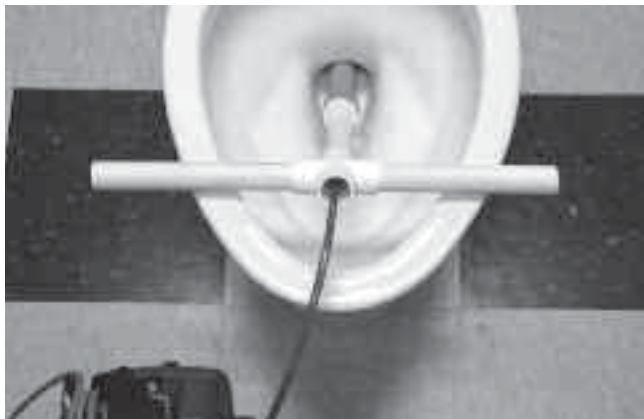
Ilustracja 24 – Używanie rurki prowadzącej z PCV
