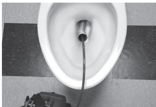
Figura 25 – Utilização de um tubo guia flexível
