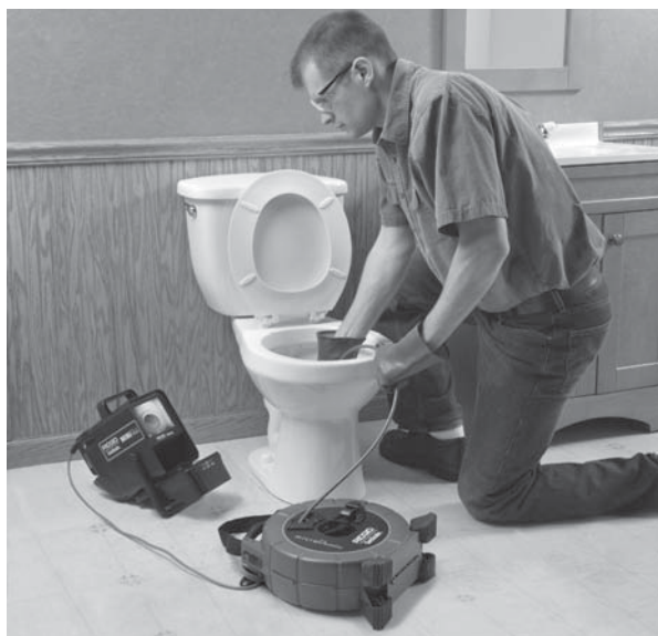
Figura 15 – Realizarea unei inspecții
