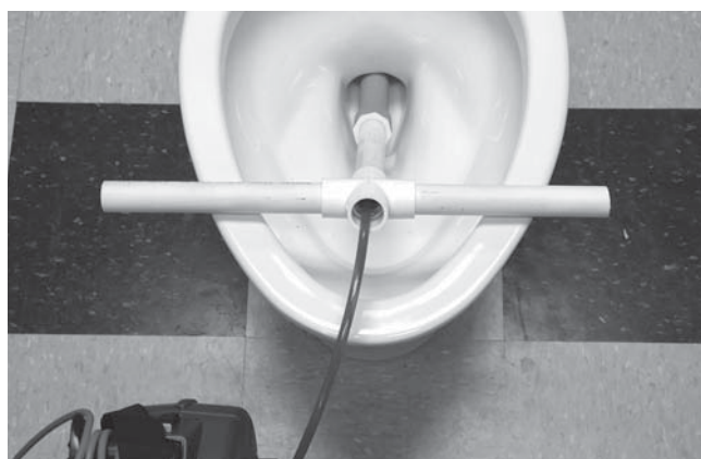
Figura 24 – Uso di un tubo guida in PVC
