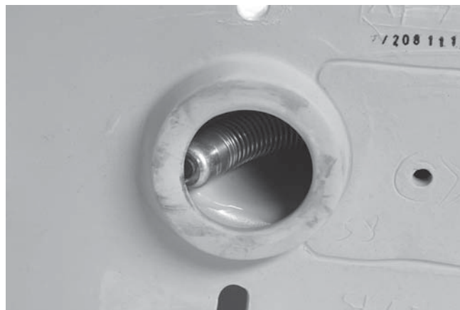
Figure 20 – Tête de caméra bloquée dans un coude
