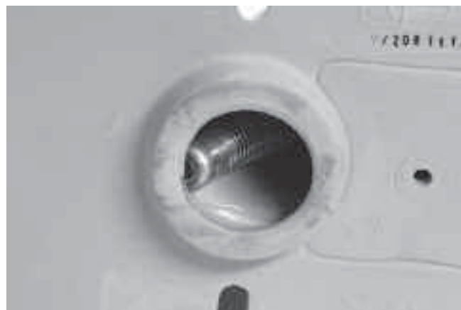
Ilustracja 20 – Głowica kamery zablokowana na zakręcie
