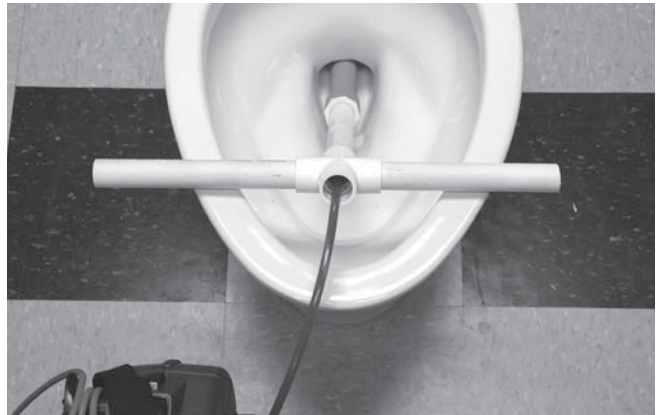
Figura 24 – Empleo de un tubo-guía de PVC
