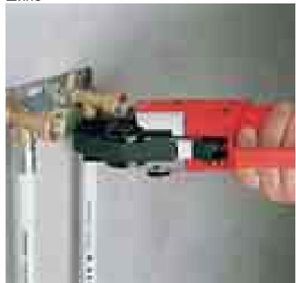
Прессовое соединение на монтажной шине
