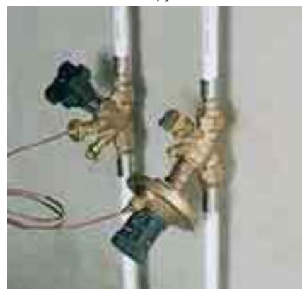
Подключение регулирующей арматуры на стойках
