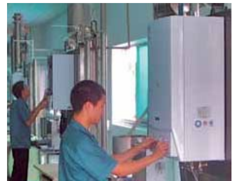
► Работа по выборочному тестированию котлов
