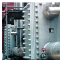
Компаблок в системе утилизации тепла жидкость-жидкость
