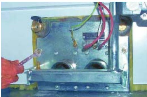
рис. 20 - Демонтаж горелок
