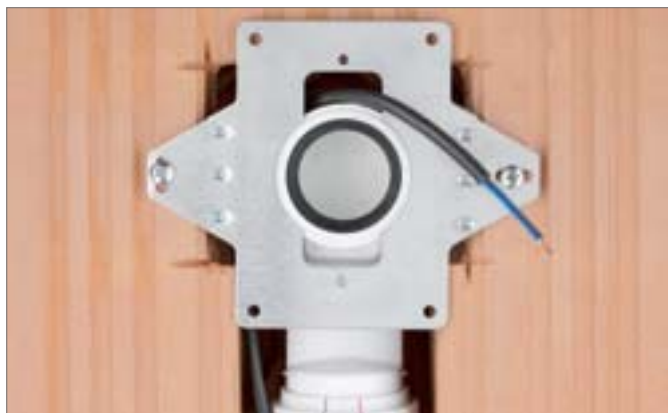
Рис. 5-3 Смонтированная монтажная рамка
