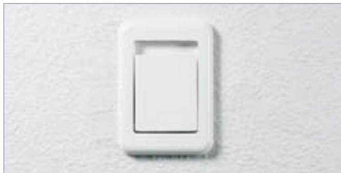
Рис. 5-6 Полностью смонтированная всасывающая розетка (радиоуправление / кабель)
