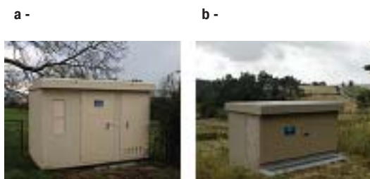
Рис. В53. На уровне земли [a], полуподземная [b]
