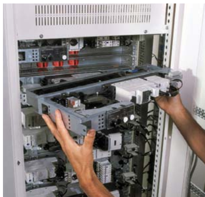
Рис. E31. РУ с втычными функциональными блоками
