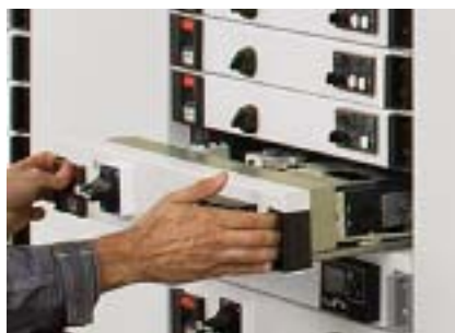
Рис. E32. РУ с выдвжными функциональными блоками
