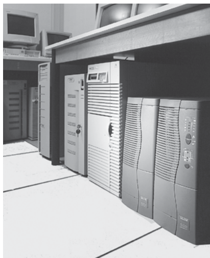
Рис. N30b. Блок ИБП, повышающий надежность, доступность и качество электропитания компьютерной системы
