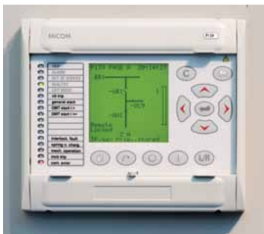
Блок управления ячейкой MICOM
