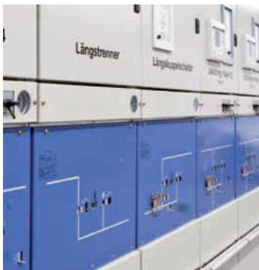
Распредустройство GMA с манометром
