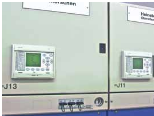
Блок управления ячейкой MICOM в РУ GMA
