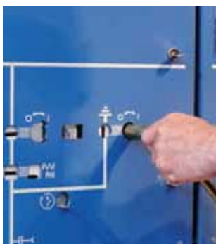
Механическое обслуживание заземлителя
