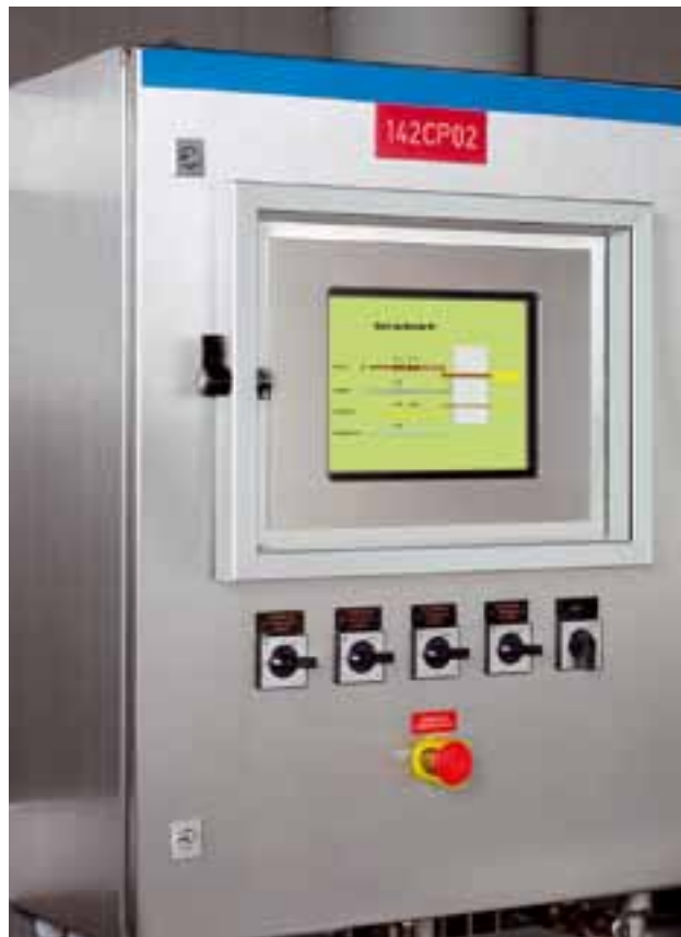
Автоматика BMS с сенсорным дисплеем на четыре горелки.
