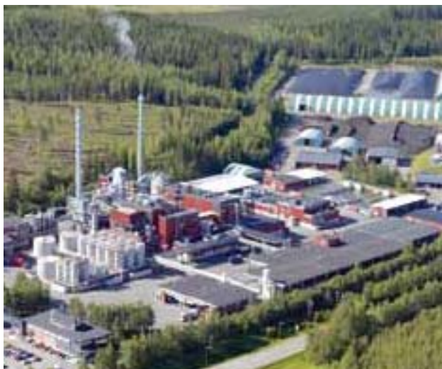
Предприятие по сжиганию ядовитых и бытовых отходов
