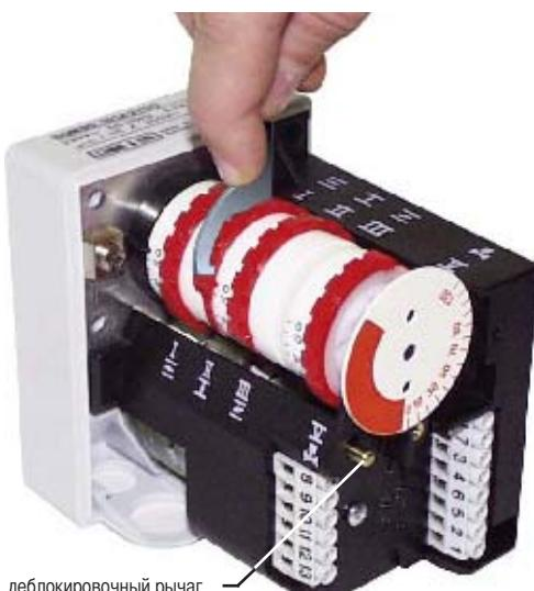
Для доступа к регулировочным кулачкам снять крышку. Регулирование выполняется входящим в комплект ключом.
