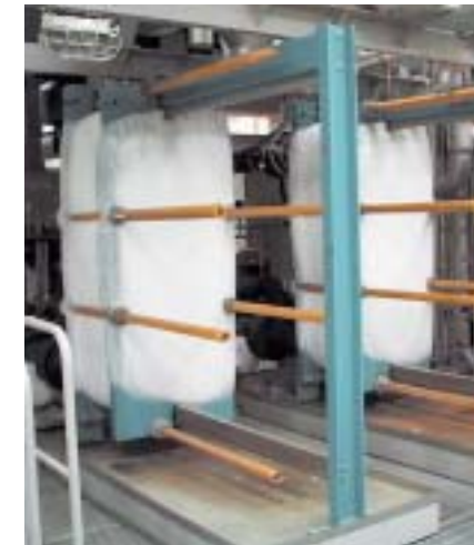
Рис. 5. Благодаря гибкой конструкции, теплообменник не разрушается при замерзании.
