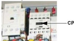
3. выпустить воздух со штуцера (M) манометра насоса (Рис. 13), расслабив слегка заглушку, но не снимая ее; затем отпустить контактор.
