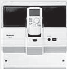
Logamatic 4122 с пультом управления MEC2
