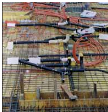
Трубопровод, заделываемый в бетон
