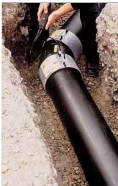
Электросварная муфта-стяжка
