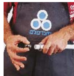
3 Вставка соединителя в трубу
