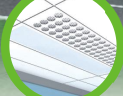
Воздухораспределительное устройство Coadis 2 или Combi Соединено с канальным вентиляторным доводчиком Major
