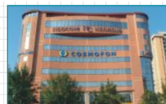
Офисное здание Kosmofon Неоком Македония
