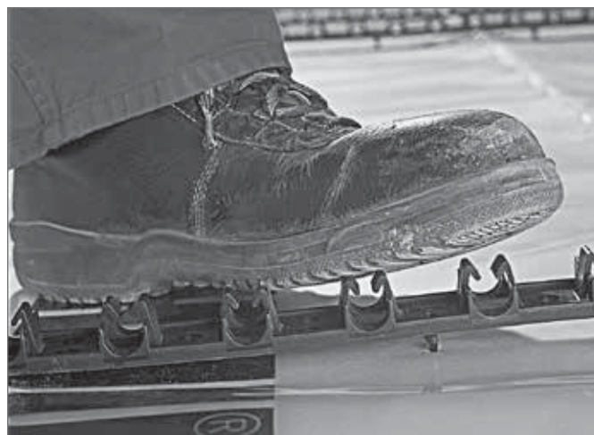
Рис. 15-46 Вдавливание фиксирующих шин RAUFIX в конструкцию пола
