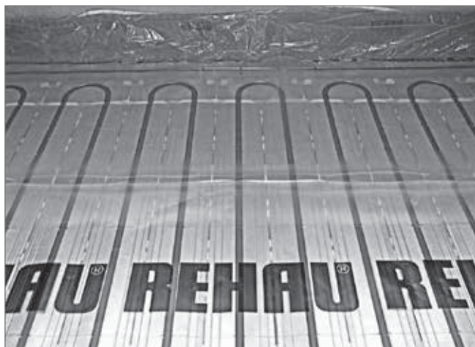
Рис. 16-1 Система укладки труб на теплоизоляционных матах TS-14
