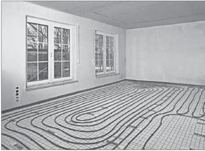
Рис. 15-33 Система крепления труб с помощью гарпун-скоб
