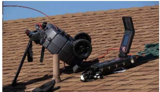
Рисунок 16 – rM200 и подставка во время проведения инспекции на крыше
