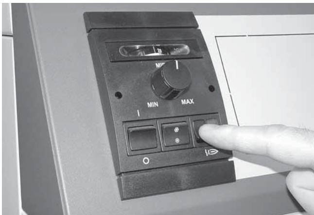
Рис. 22: Кнопка перезапуска горелки
