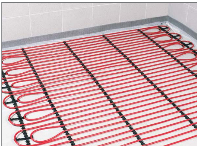
Рис. 3-68 Напольная фиксирующая шина для мокрого способа монтажа
