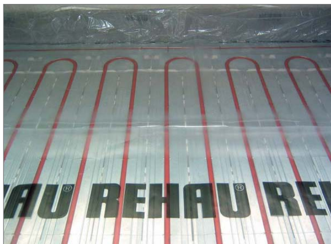
Рис. 3-59 Система укладки труб на теплоизоляционных матах TS-14
