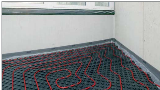
Рис. 3-11 Маты с фиксаторами Varionova с шаго-звукоизоляцией 30-2 снизу
