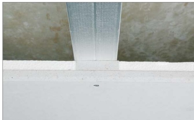
Рис. 4-6 Крепление потолочных панелей
