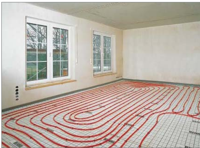
Рис. 3-22 Система крепления труб с помощью гарпун-скоб
