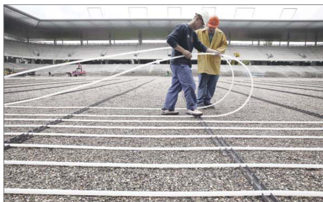
Рис. 9-34 Укладка отопительных труб
