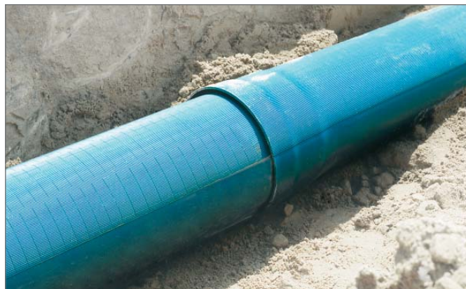
Рис. 9-33 Укладка дренажа на игровом поле
