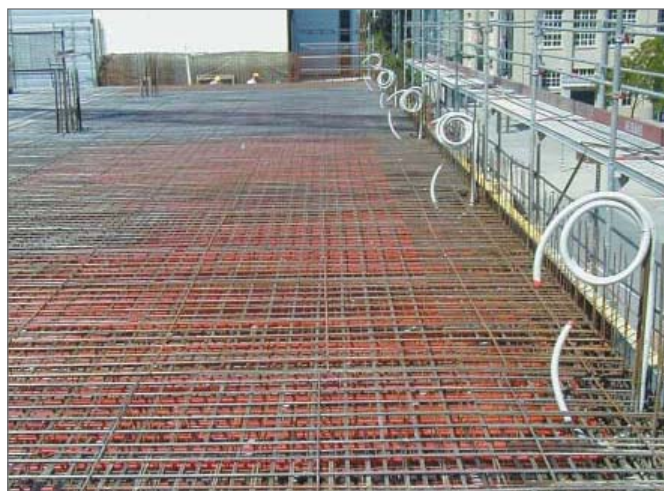
Рис. 8-2 Участок бетонирования ВКТ
