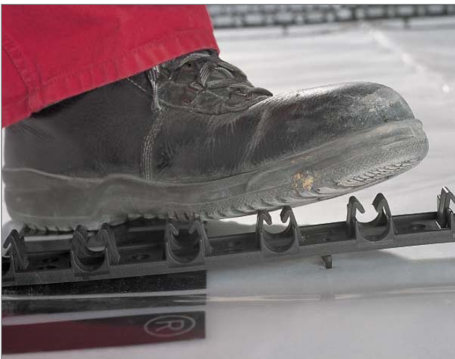
Рис. 3-34 Вдавливание фиксирующих шин RAUFIX в конструкцию пола
