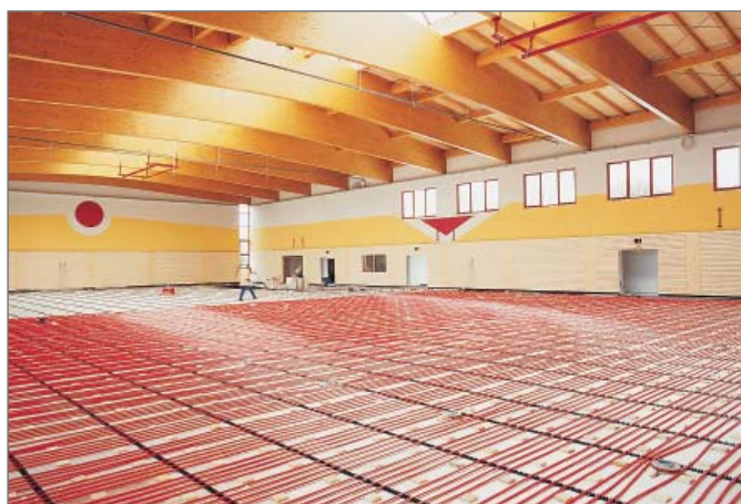
Рис. 9-17 SBH Система со стандартным распределительным коллектором
